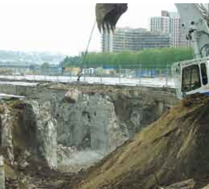
Photo 3 : Des travaux de requalification de friche – Destruction d'infrastructures bétonnées.
