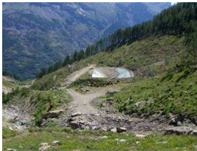
Figure 2 – Retenue d'altitude impactée par une avalanche (crédit : Cemagref)
