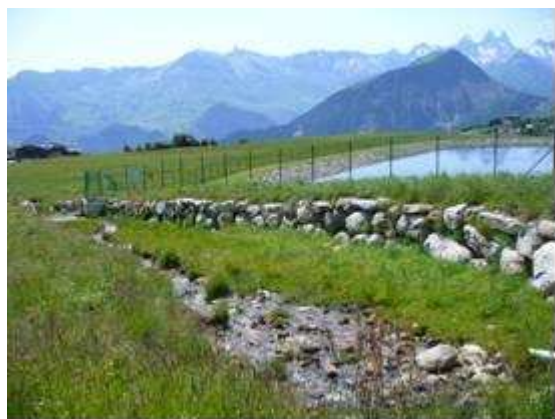
Figure 3 – Retenue soumise à un risque torrentiel avéré (crédit : Cemagref)
