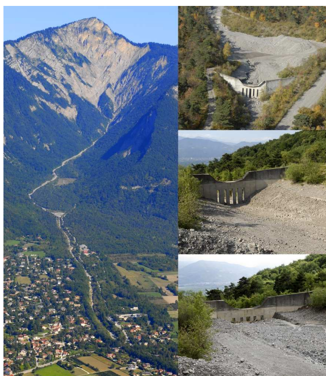
Figure 2. Bassin d'alimentation et plage de dépôt RTM du torrent du Manival en Isère, France (© S. Gominet, Irma)
