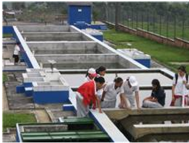
ACUEDUCTO MUNDO NUEVO Pereira - Colombia
