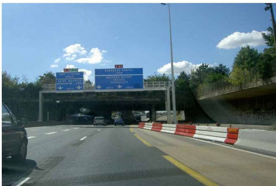
Figure 7 : Le site A4-A86 après aménagement
