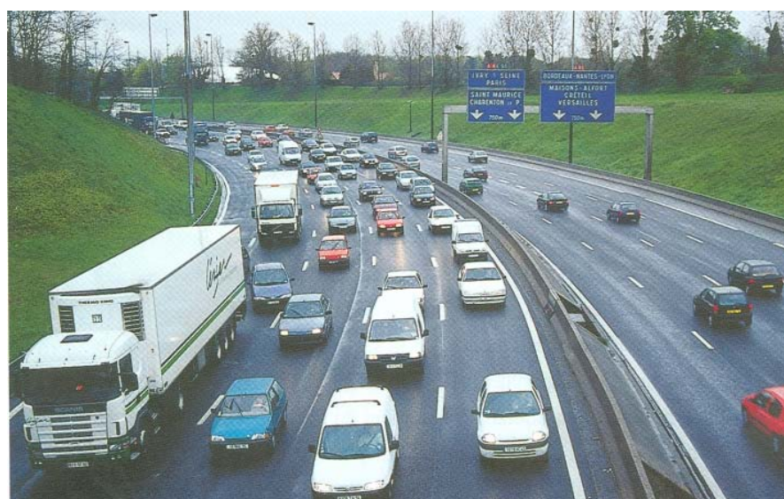
Figure 4 : Tronc commun A4-A86 avant aménagement (source DIRIF)
