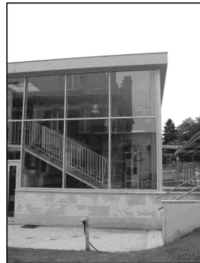
Figure 10. Façade nord-ouest de la pièce équipée
